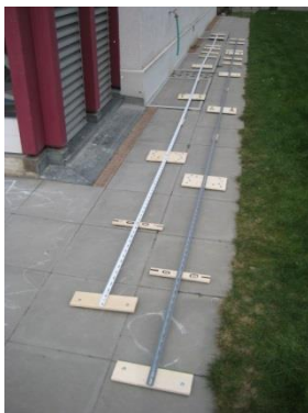
Schienen ausgelegt ca. 9.50 m
